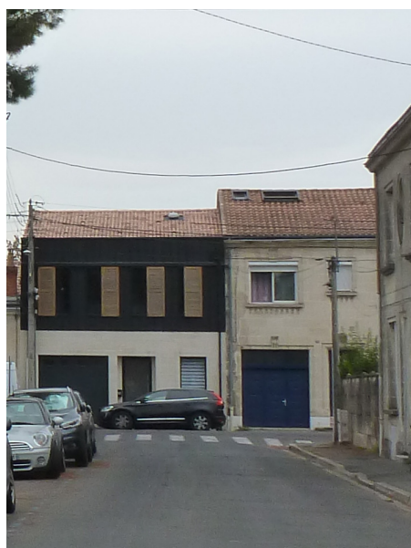
Photo d'échoppes «R+1+combles» rue Jules Vallès
