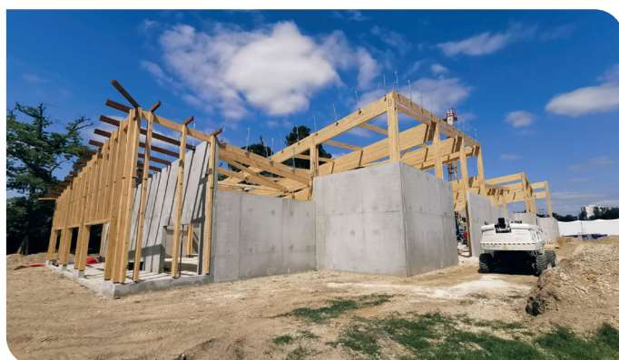
▲ Le pôle administratif et sportif en construction
