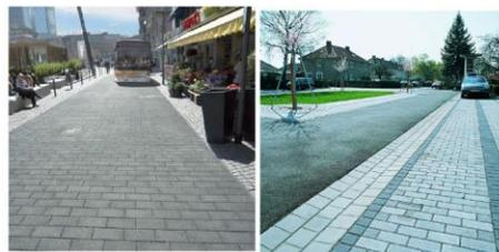
Proposition 03 : voirie en pavés et caniveaux en pavés béton
