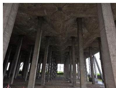
Figure 5 : "forêt" de pieux béton armé soutenant les 2 réservoirs (photo CE)
